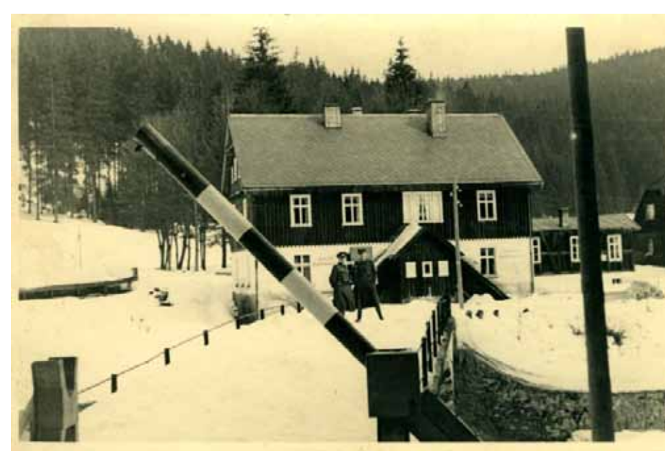
původní železobetonový most
