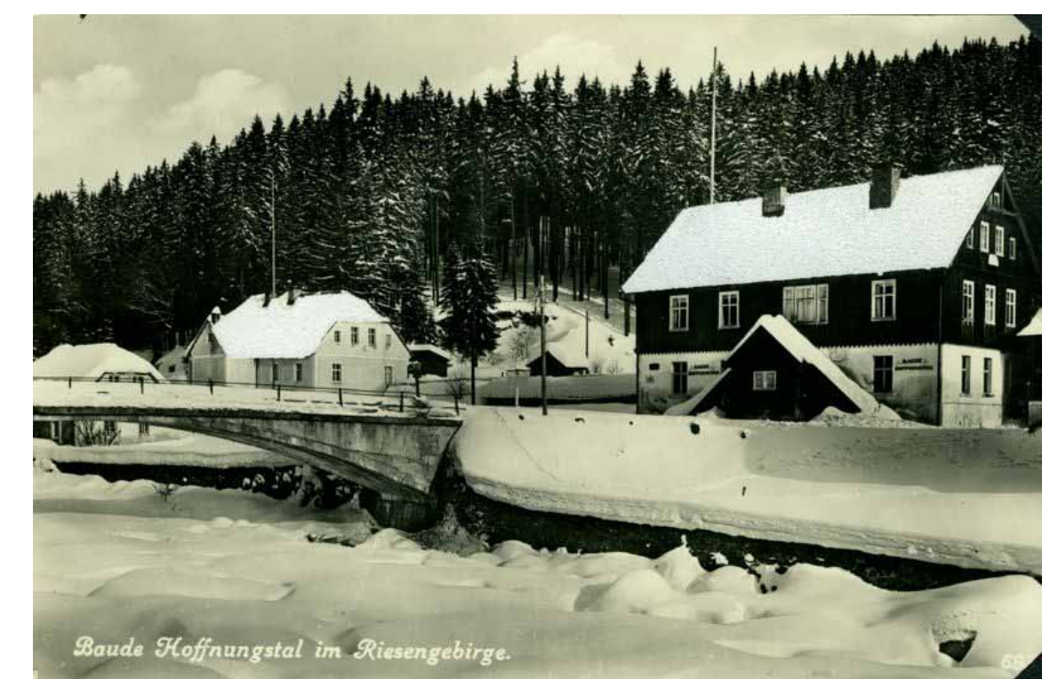
původní železobetonový most
