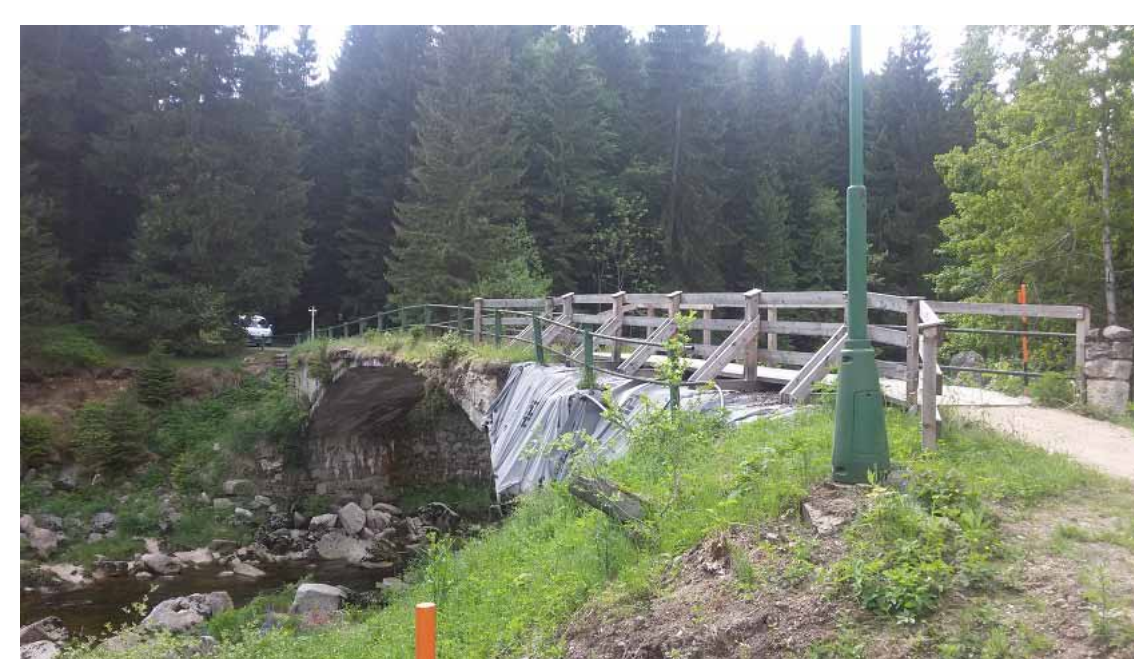
stav most před rekonstrukcí v roce 2019
